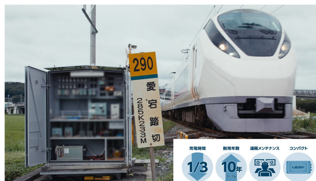
図8 踏切保安器用バックアップ電源(鉛代替)
