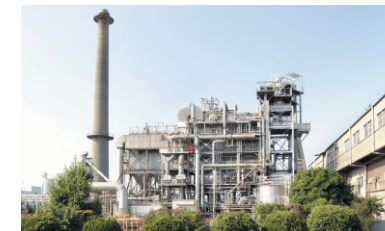
シュレッターダスト再資源化施設(追浜工場)
