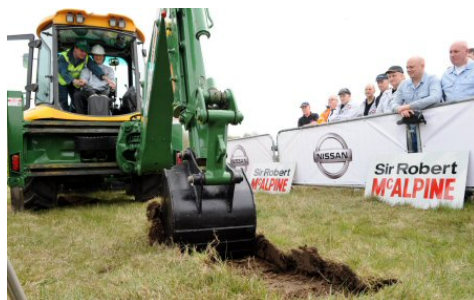
4月：バッテリー工場建設着工 (英国、サンダーランド)
