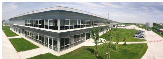
共通の補修部品物流倉庫(ハンガリー)
